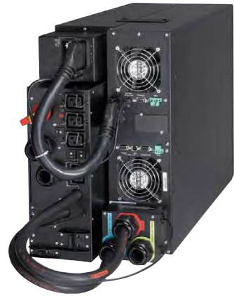
ИБП 9PX 11 кВА с сервисным блоком
